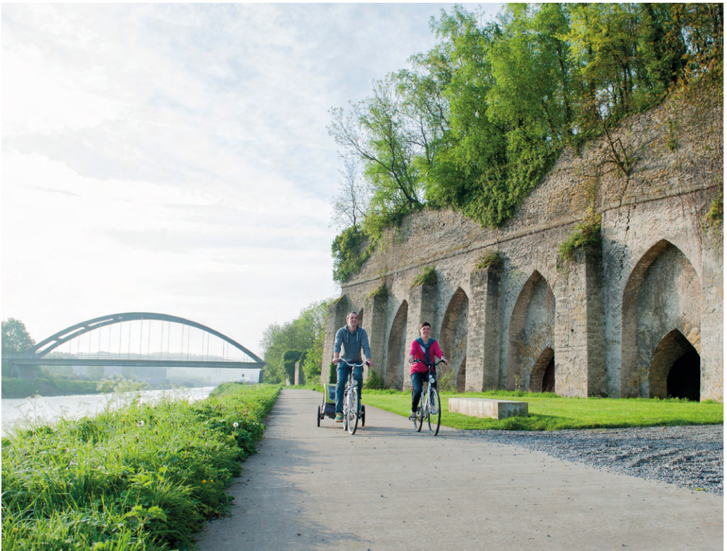
RAVeL de l'Escaut, four à chaux Saint-André (Tournai)
